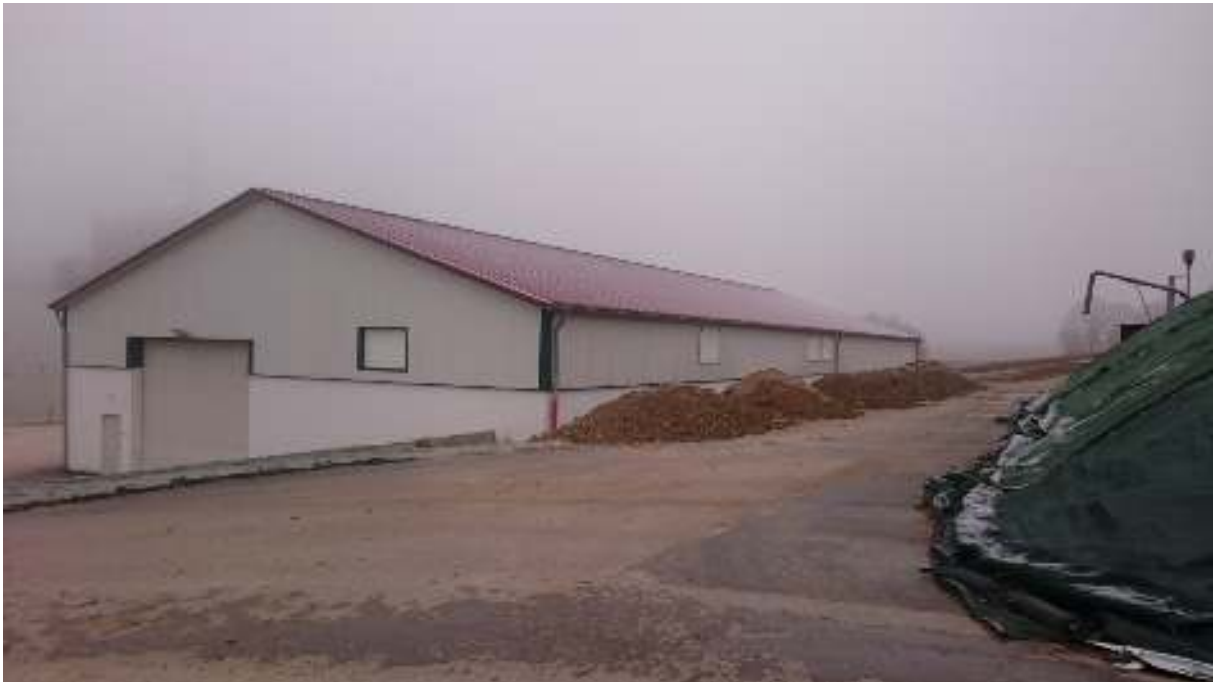
Abb. 3 Hallenbestand im Süden ( entspricht Bauraum K im Planwerk)
