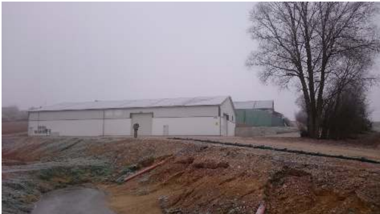
Abb. 4 aktueller südlicher Übergang in die Landschaft generiert Eingrünungsbedarf
